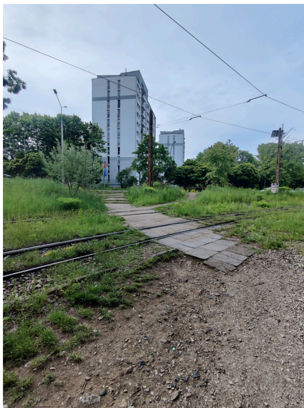
Przejście przez tory tramwajowe jest przestarzałe, płyty chodnikowe są poprzysuwane i jest ono niewidoczne dla tramwajów jadących z Pętli Radiostacja, co może powodować kolizje. Widać też że dalsza część ścieżki jest nieutwardzona.
