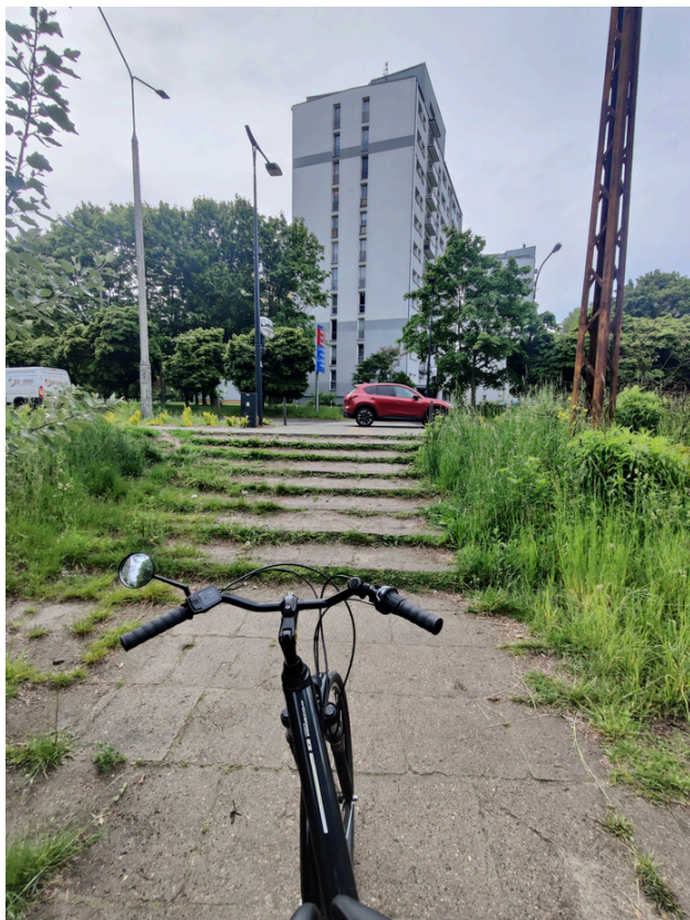
Schody prowadzą do inteligentnego przejścia przez ul. Narutowicza. Na zdjęciu widać jak bardzo są pochylone, zniszczone i zarośnięte. Przejazd rowerem lub wózkiem jest bardzo utrudniony w tym miejscu.
