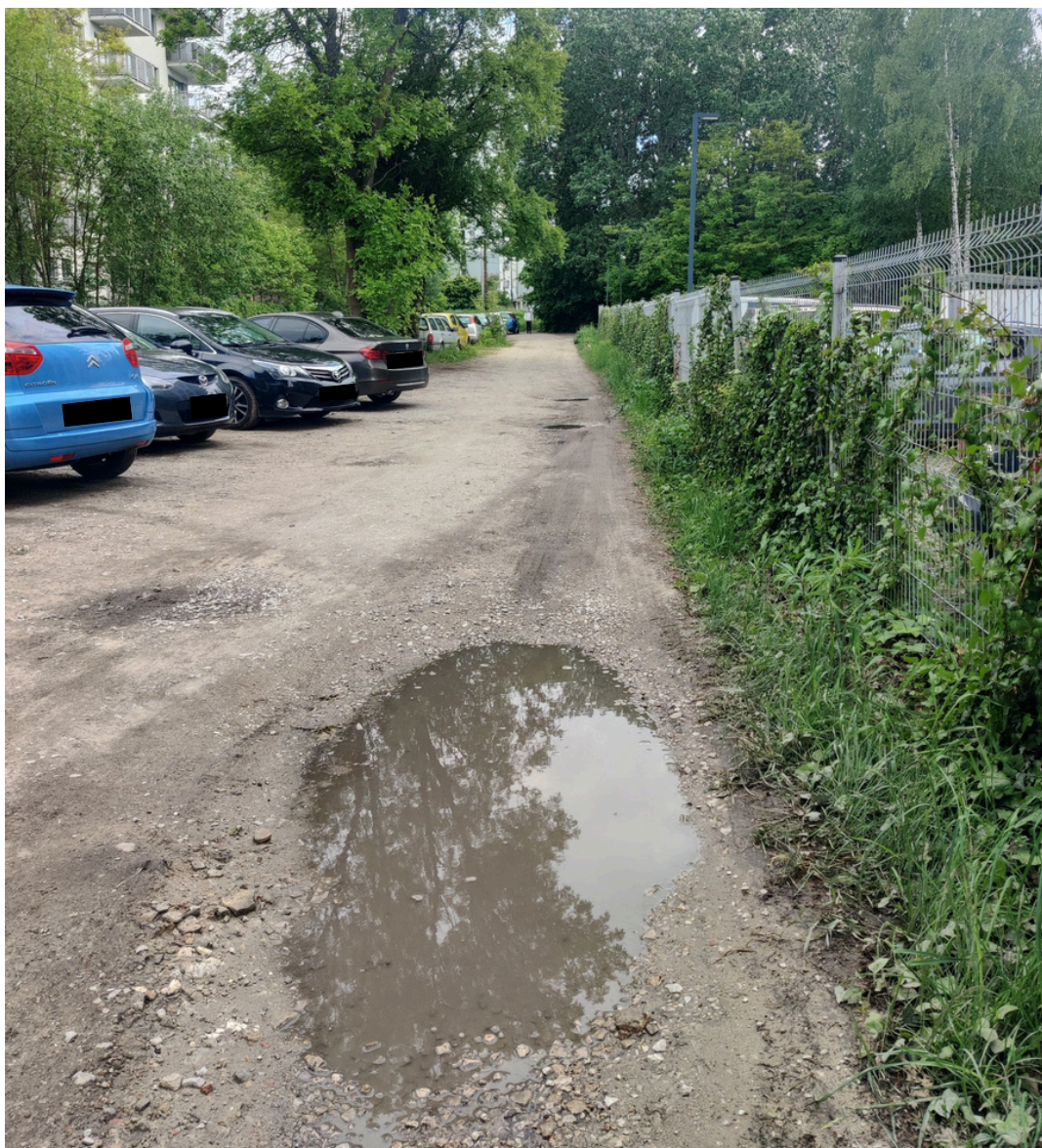
Aktualna ścieżka wymywana jest często przez deszcze. Powoduje to problemy w komunikacji i regularną degradację ścieżki.
